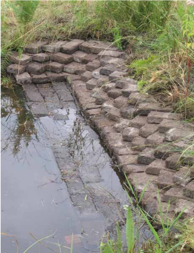
Toepassing van de turven in oeverbekleding (Foto SBB)
