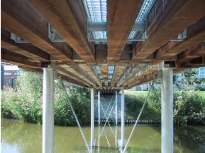
Onderzijde van de brug 'Lichtend pad' (foto Precious Woods Europe BV).
