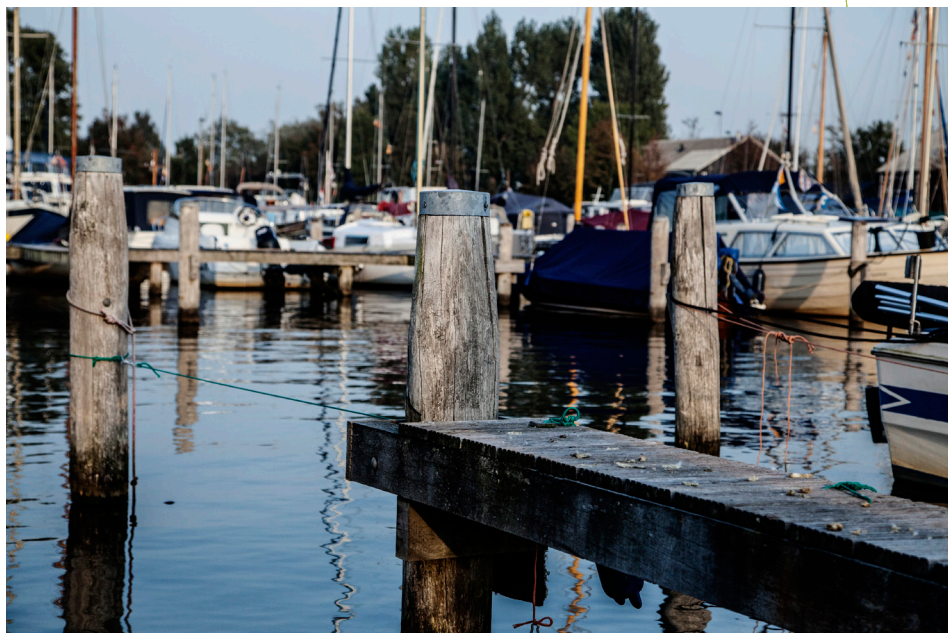
Manbarklak ronde palen in jachthaven Akkrum uit 2009 en nog steeds in goede conditie. (Foto: Mark van Benthem - Probos)
